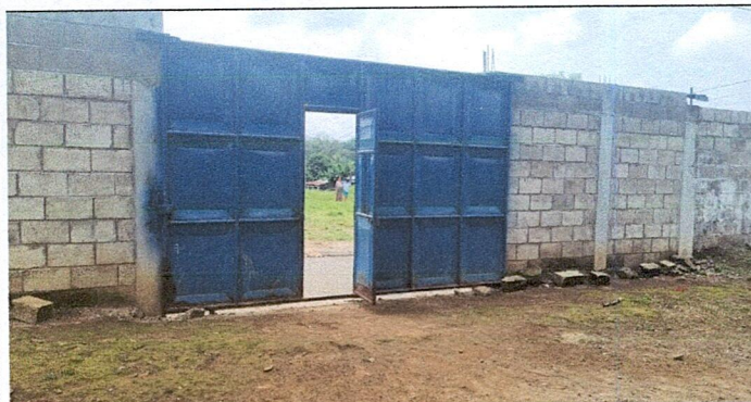
Foto 5: Mantenimiento de portón
