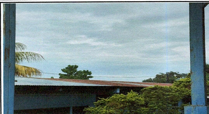
Foto 1: Mantenimiento a estructura de lamina (lijado, aplicación de pintura)
