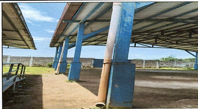
Foto 2: Reparación de bajada de agua pluvial, tubo PVC 4"
