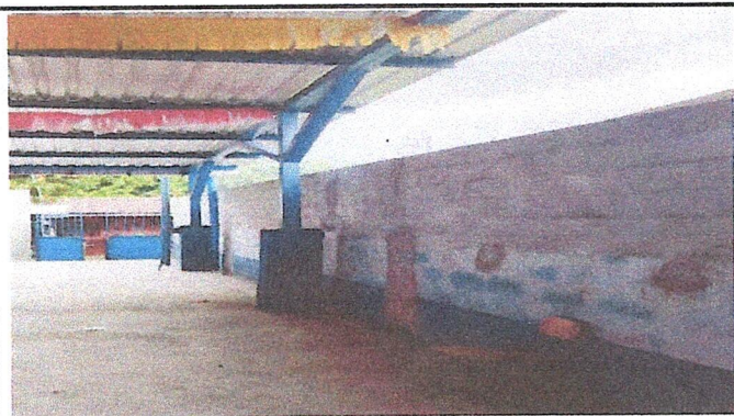
Foto 3: CONTINUIDAD DE MURO PERIMETRAL EXISTENTE CON MURO DE BLOCK DE CONCRETO
