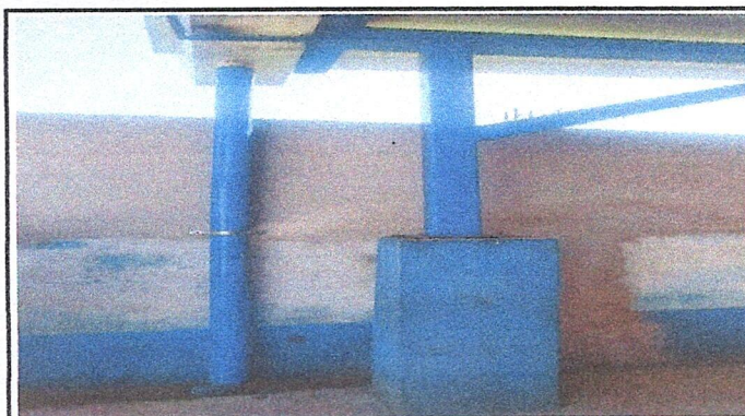
Foto 3: SUMINISTRO DE CANAL DE METAL DE BAJADA PLUVIAL.
