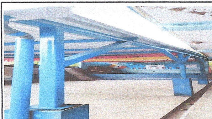
Foto 4: SUMINISTRO DE ESTRUCTURA EN REFORZAMIENTO EN CUBIERTA DE PATIO.
