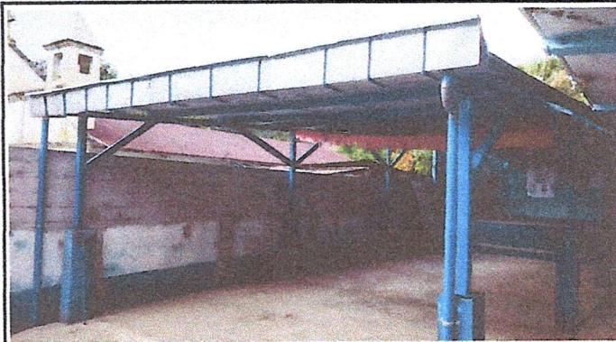
Foto 2: SUMINISTRO DE CUBIETA DE LÁMINA TROQUELADA ALUZINC CALIBRE 26 EN PATIO Y SERVICIOS SANITARIOS
