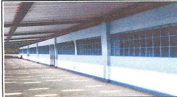
Foto 6: SUMINISTRO DE BALCONES METAL
