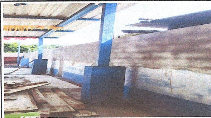
Foto 4: APLICACIÓN DE REPELLO EN PAREDES DE MURO PERIMETRAL
