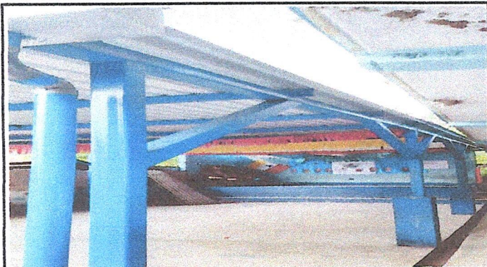
Foto1: SUMINISTRO DE CUBIETA DE LÁMINA TROQUELADA ALUZINC CALIBRE 26 EN PATIO Y SERVICIOS SANITARIOS
