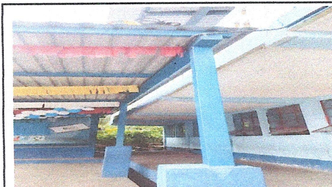
Foto 3: SUMINISTRO DE CANAL DE METAL DE BAJADA PLUVIAL.
