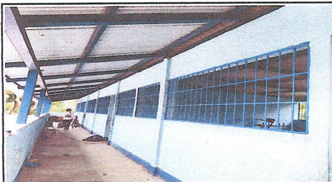
Foto 5: SUMINISTRO DE BALCONES METAL
