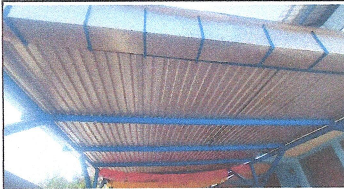
Foto1: SUMINISTRO DE CUBIERTA DE LÁMINA TROQUELADA ALUZIN CALIBRE 26 EN PATIO Y SERVICIOS SANITARIOS
