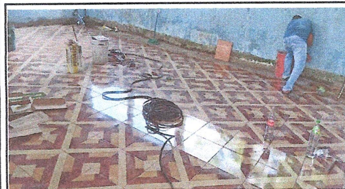
Foto 5: SUSTITUCIÓN DE PISO DE TORTA DE CEMENTO POR PISO CERAMICO EN AULA DE SEGUNDO NIVEL
