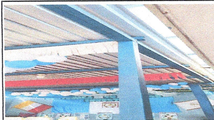
Foto 4: SUMINISTRO DE ESTRUCTURA EN REFORZAMIENTO EN CUBIERTA DE PATIO.
