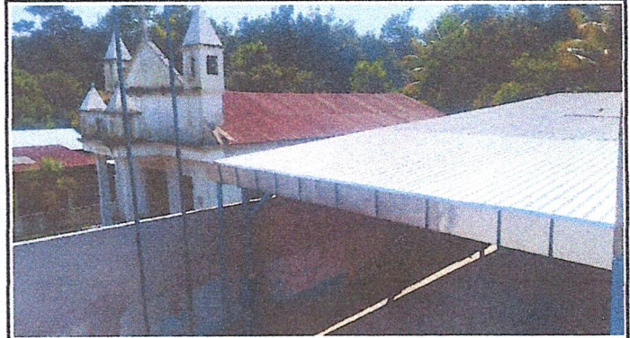
Foto 2: SUMINISTRO DE CUBIERTA DE LÁMINA TROQUELADA ALUZIN CALIBRE 26 EN PATIO Y SERVICIOS SANITARIOS
