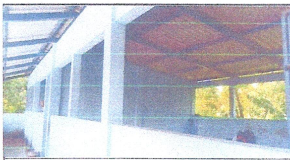
Foto 5: SUMINISTRO DE BALCONES METAL
