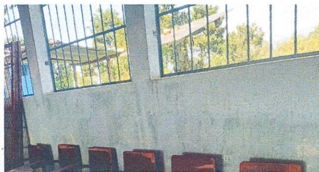
Foto 5: SUMINISTRO DE VENTANA DE UPVC
