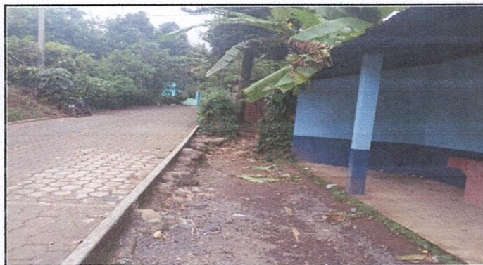
Foto 4: SE REALIZARA LA SUSTICIÓN DE ESTRUCTURA DE SOPORTE DE METAL POR ESTRUCTURA DE METAL
