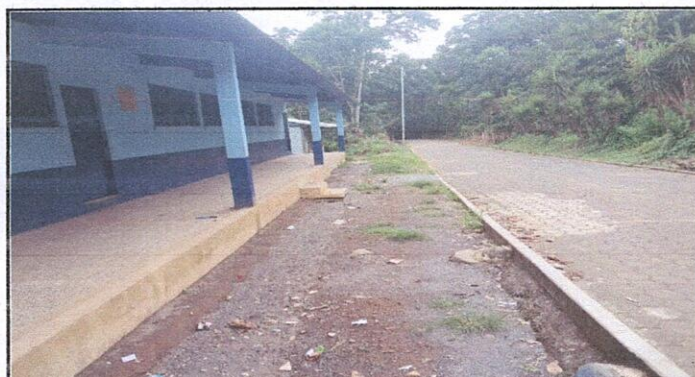
Foto 3: SE REALIZARA LA SUSTICIÓN DE ESTRUCTURA DE SOPORTE DE METAL POR ESTRUCTURA DE METAL
