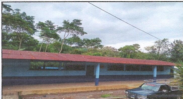
Foto 1: SE REALIZARA LA SUSTITUCIÓN DE LÁMINA POR LÁMINA TROQUELADA CALIBRE 26
