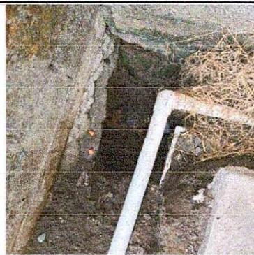
Foto 2: Suministro de caja de registro de drenaje de 0.90 x 0.90
