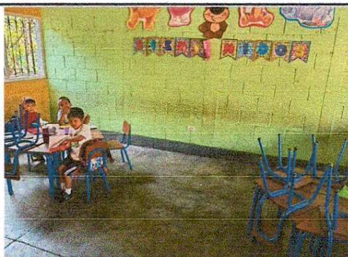
Foto 3: Aplicación de pintura + sustitución de piso cerámico
