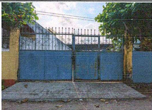
Foto1: Sustrucción de portón de metal de 2.00 x 4.20 + Suministro de rampa de ingreso principal
