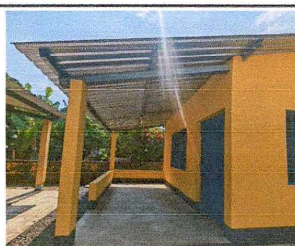
Foto 6: Suministro de canales de agua pluvial
