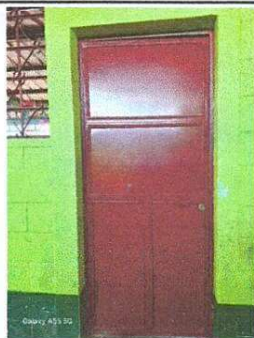
FOTO 3: Mantenimiento a estructura de puerta de metal
