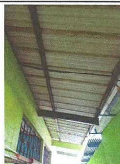
FOTO 4: Mantenimiento a estructura de soporte de metal + sustitución de lámina troquelada aluzinc calibre 26
