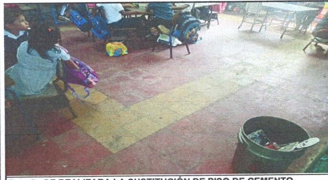
Foto 5: SE REALIZARA LA SUSTITUCIÓN DE PISO DE CEMENTO LIQUIDO POR PISO CERÁMICO EN AULAS.
