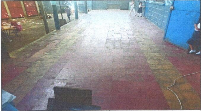
Foto 2: SE REALIZARA LA SUSTITUCIÓN DE PISO DE CEMENTO LIQUIDO PISO CERAMICO.
