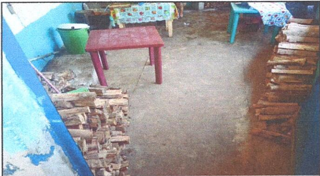
Foto 1: SE REALIZARA EL SUMINISTRO DE MUEBLE DE COCINA DE CONCRETO MAS REVESTIMIENTO DE AZULEJO.
