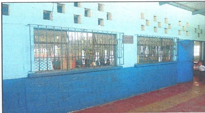
Foto 3: SE REALIZARA EL MANTENIMIENTO A BALCONES Y SUSTICIÓN DE VENTANAS TIPO BALANCIN POR VENTANAS PVC
