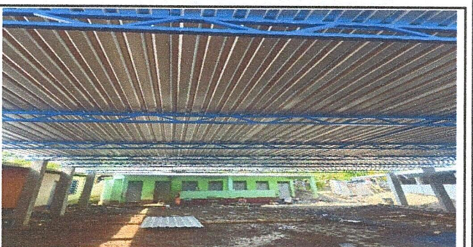
Foto 6: Instalación de Columnas de 20 cm x 25 cm x 4.40
