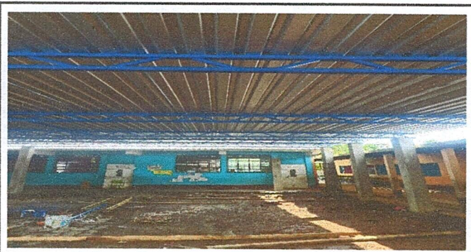
Foto 5: Instalación de Columnas de 20 cm x 25 cm x 4.40
