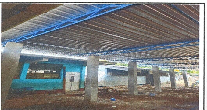
Foto 4: Sustrucción de estructura de soporte de madera por metal y de techo de lámina por lámina troquelada aluzinc calibre 26 en el área recreativa del edificio educativo.
