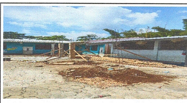
Foto 6: Instalación de Columnas de 20 cm x 25 cm x 4.40
