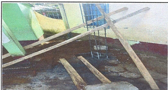
Foto 5: Instalación de Columnas de 20 cm x 25 cm x 4.40
