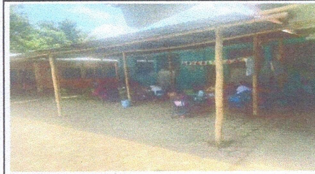
Foto 4: Sustrucción de estructura de soporte de madera por metal y de techo de lámina por lámina troquelada aluzinc calibre 26 en el área recreativa del edificio educativo.
