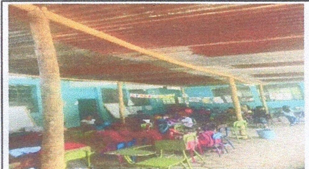
Foto 3: Sustrucción de estructura de soporte de madera por metal y de techo de lámina por lámina troquelada aluzinc calibre 26 en el área recreativa del edificio educativo.
