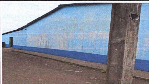
Foto 1: Aplicación de pintura en muros exteriores e interiores
