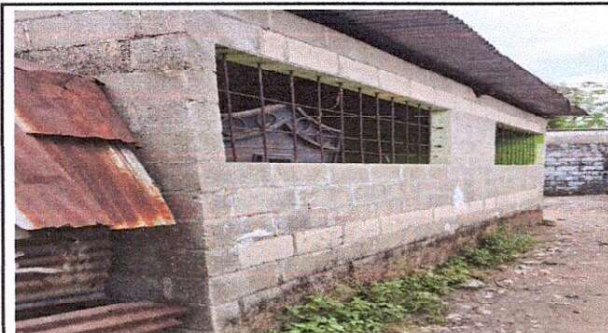
Foto 6: Mantenimiento a balcones de metal
