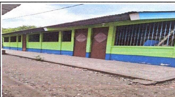
Foto 3: Sustitución de puertas
