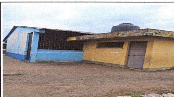
Foto 4: Reparación de losa de patio
