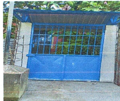
Foto 12: Referencia renglon 3.2, y 3.3 (suministro de estructura metalica de soporte de techo + lamina troquelada calibre 26, y sustitución de porton de metal)
