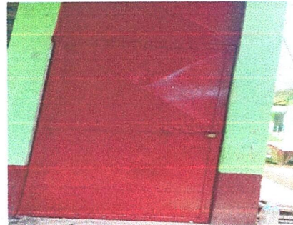
Foto 10: Referencia renglon 2.2 (reparacion de puerta de metal).
