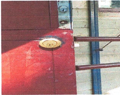
Foto 9: Referencia renglon 2.1 (suministro de de chapa)
