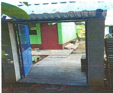
Foto 11: Referencia renglon 3.1 (sustitución de columnas de concreto armado)
