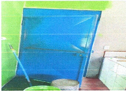
Foto 7: Referencia renglon 1.12 (suministro de puerta de metal con chapa yale).
