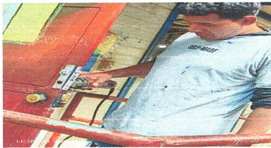
Foto 9: Referencia renglon 2.1 (suministro de de chapa)
