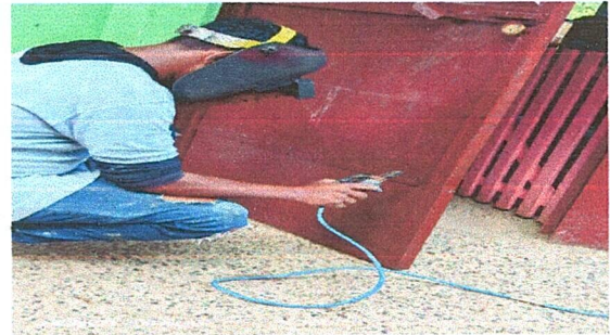
Foto 10: Referencia renglon 2.2 (reparacion de puerta de metal).
