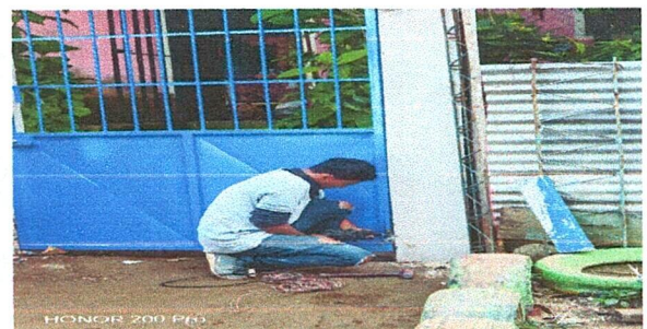
Foto 12: Referencia renglon 3.2, y 3.3 (suministro de estructura metalica de soporte de techo + lamina troquelada calibre 26, y sustitución de porton de metal)
