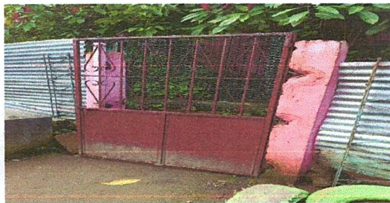
Foto 11: Referencia renglon 3.1 (sustitución de columnas de concreto armado)
