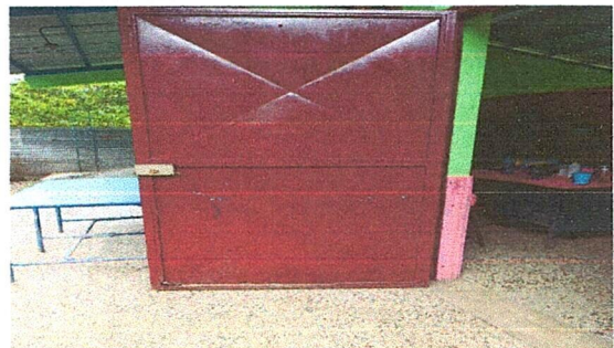
Foto 10: Referencia renglon 2.2 (reparacion de puerta de metal).
