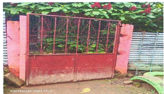
Foto 12: Referencia renglon 3.2, y 3.3 (suministro de estructura metalica de soporte de techo + lamina troquelada calibre 26, y sustitución de porton de metal)
