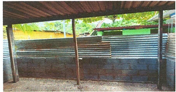
Foto 8: Referencia renglon 1.13 y 1.14 (suministro de ventanas de pvc, y balcones de metal)
