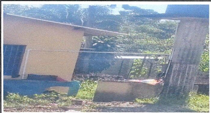
Foto 5: Suministro de cubierta de techo para protección de área de pila
