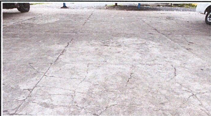
Foto 1: Sustitución de losa de concreto
