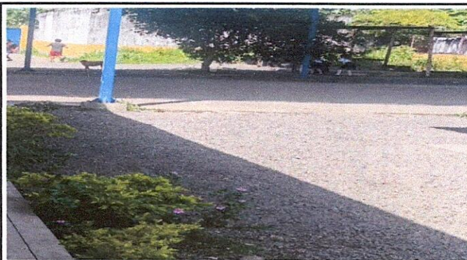
Foto 4: Sustitución de losa de concreto
