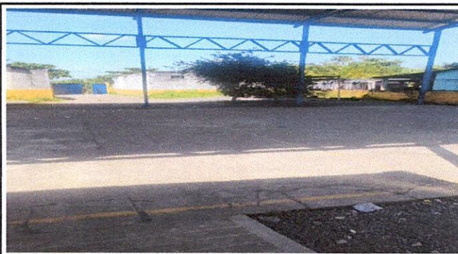
Foto 2: Sustitución de losa de concreto
