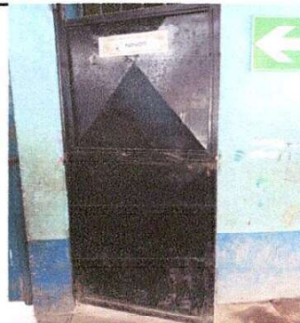
Foto 4: Sustitución de puertas de metal
