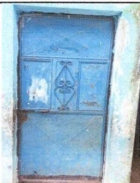
Foto 3: Sustitución de puertas de metal
