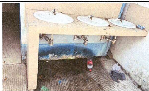
Foto 6: Mantenimiento de lavamanos (cambio de accesorios)
