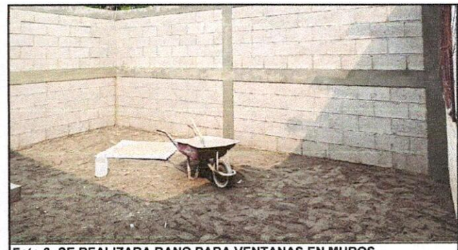
Foto 6: SE REALIZARA BANO PARA VENTANAS EN MUROS
