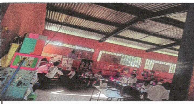
Foto 6: sustitución de piso en aula # 2
