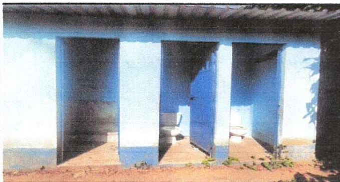
Foto 3: suministro de azulejo en el area de migitorio, sustitución de piso, sustitución de accesorios, aplicación de pintura
