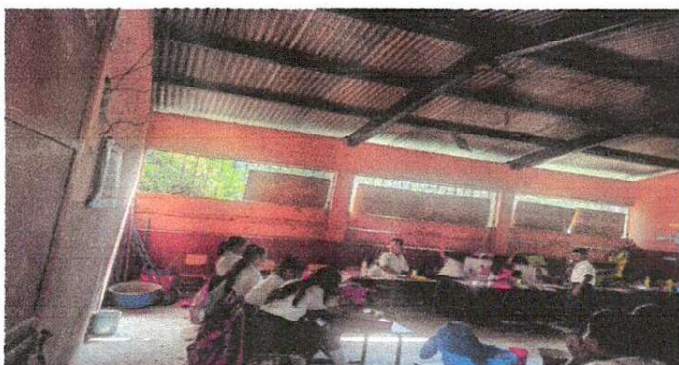
Foto 5: sustitución del sistema electrico
