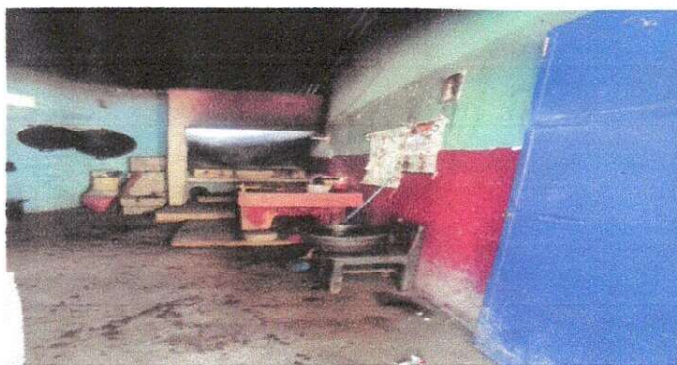
Foto 4: aplicación de repello en la paredes exteriores, sustitución de piso, suministro de azulejo en el area de trabajo + pila, aplicación de pintura interior y exterior, sustitución de ventana y sustitución del sistema
