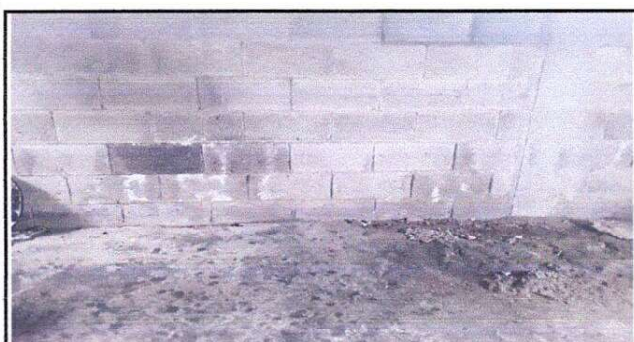
Foto 5: Construcción de un polieton con plancha
