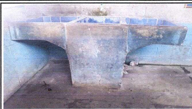
Foto 2: Sustitución de pila por pila de concreto
