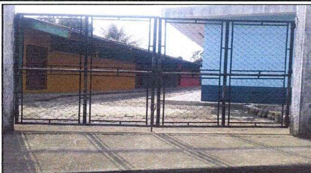
Foto 1: Mantenimiento a portones de metal, quitar la mitad de maya y colocar lámina.
