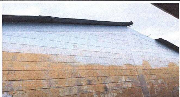
Foto 4: Aplicación de repello y cernido de paredes (sellado de grietas y fisuras en muros)
