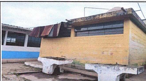
Foto 1: Sustitución de pilas
