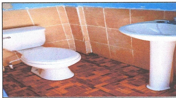
Foto 6: Se realizará la sustitución de lavamanos por lavamanos de porcelana en pedestal.
