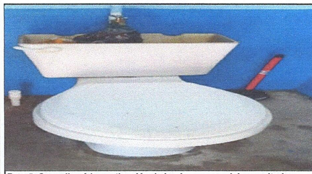
Foto 5: Se realizará la sustitución de inodoro en servicios sanitarios
