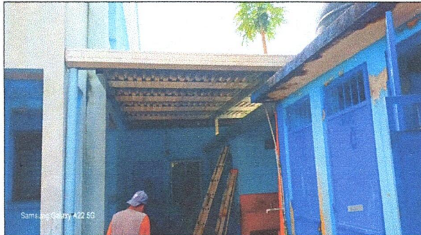
Foto 1: Se realizará la instalación de cubierta de lámina + estructura de techo
