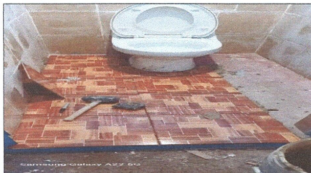
Foto 3: Se realizará la instalación de piso cerámico en servicios sanitarios
