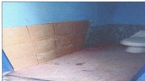
Foto 4: Se realizará la instalación de azulejos en paredes de servicio sanitarios
