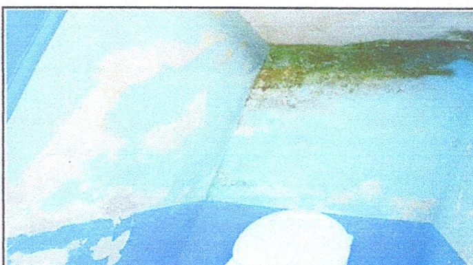
Foto 4: Se realizará la instalación de azulejos en paredes de servicios sanitarios
