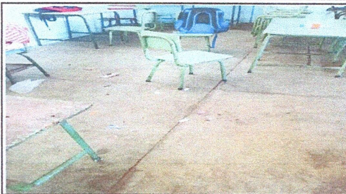
Foto 2: Se realizará la instalación de piso cerámico en aulas y pasillo
