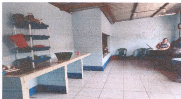
Foto1: Sustitución de piso de cemento por piso cerámico en cocina
