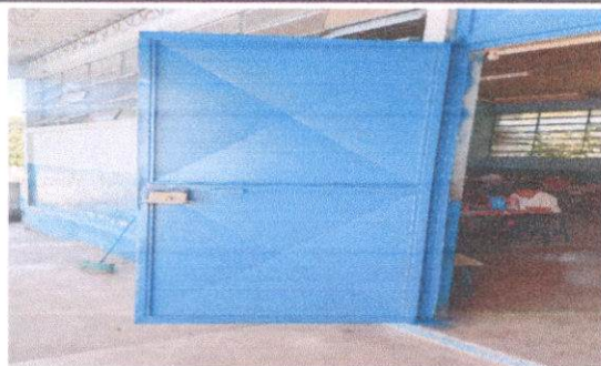
Foto 5: Reparación y mantenimiento a puertas de metal (incluyendo cepillado y aplicación de pintura)
