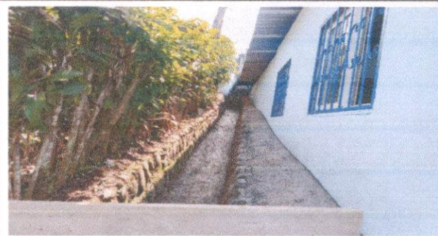
Foto 4: Reparación de cuneta de concreto
