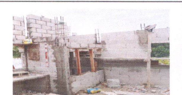
Foto 6: Sustitución de chimenea de concreto
