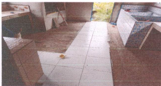
Foto1: Sustitución de piso de cemento por piso ceramico en cocina
