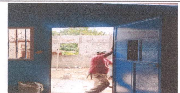
Foto 5: Reparación y mantenimiento a puertas de metal (incluyendo cepillado y aplicación de pintura)
