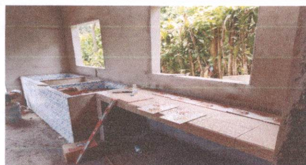
Foto 3: Revestimiento de azulejo en mueble de cocina
