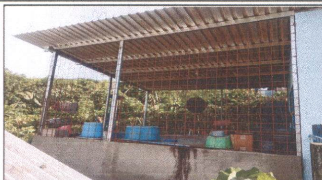
Foto 2: Sustitución de electromaya por continuación de muro de block
