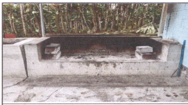
Foto 6: Sustitución de chimenea de congre en estufa rural
