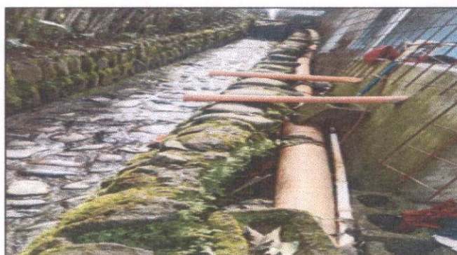
Foto 4: Reparación de cuneta de concreto
