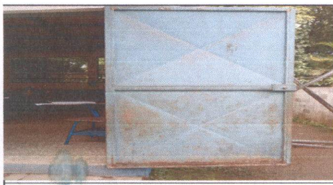
Foto 5: Reparación y mantenimiento a puertas de metal (incluye cepillado lijado + aplicación de pintura)
