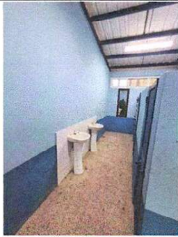
FOTO 1: Suministro de azulejo en módulo de baños
