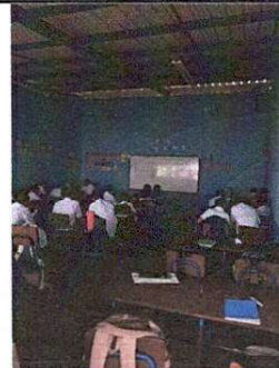
FOTO 6: Sustitución de lámina en módulo de aulas
