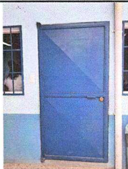
FOTO 5: Sustitución de chapa de puerta de metal
