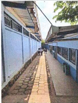
FOTO 3: Suministro de ventanas
