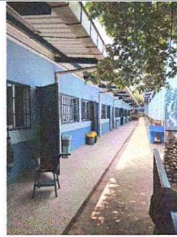
FOTO 2: Sustitución de lámina en módulo de aulas
