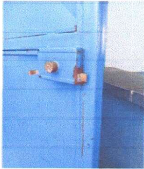
FOTO 1: Mantenimiento de puerta de metal de 1.00 x 2.00 (cambio de chapa)
