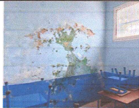
FOTO 4: Aplicación de impermeabilizante en paredes interiores y exteriores de módulo de aulas
