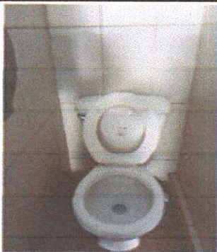
FOTO 3: Sustitución de accesorios de inodoro
