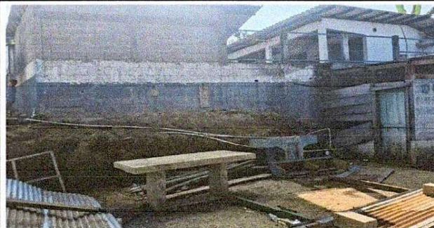
Foto 2: Repello en interior y exterior de muro perimetral.
