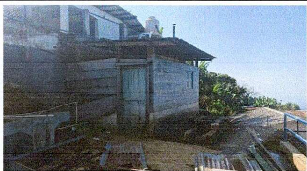
Foto 1: Sustitución de lámina y estructura de techo de madera por metal. Suministro de balcones de metal. Sustitución de puerta de madera por puerta de metal en cocina.
