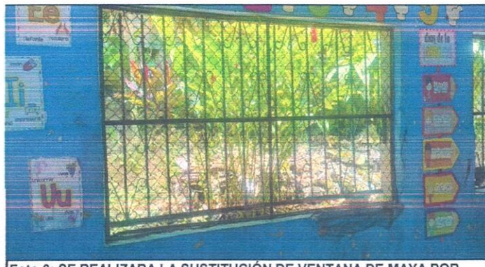
Foto 6: SE REALIZARA LA SUSTITUCIÓN DE VENTANA DE MAYA POR VENTANA DE MAYA CON MARCO DE METAL
