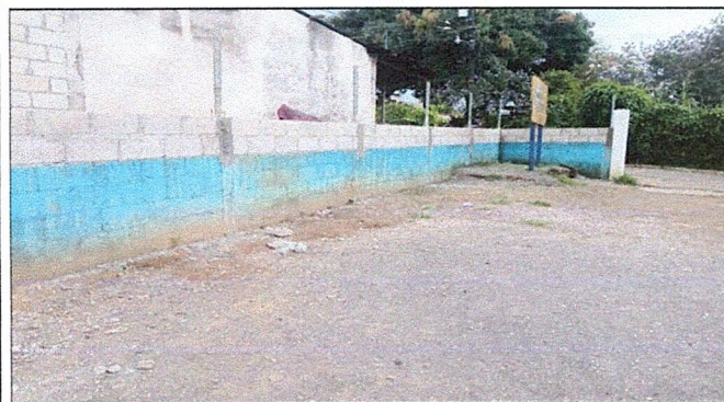
Foto 3: Mejoramiento de altura de muro perimetral
