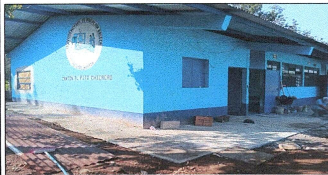
Foto 5: Reparación de banqueta de concreto
