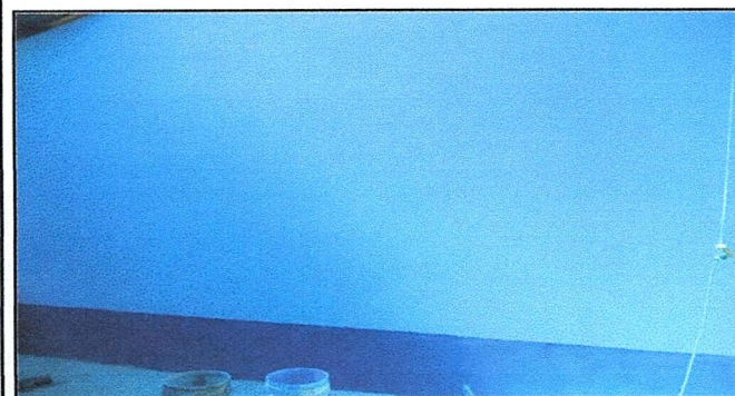
Foto 5: Aplicación de repello en área de cocina
