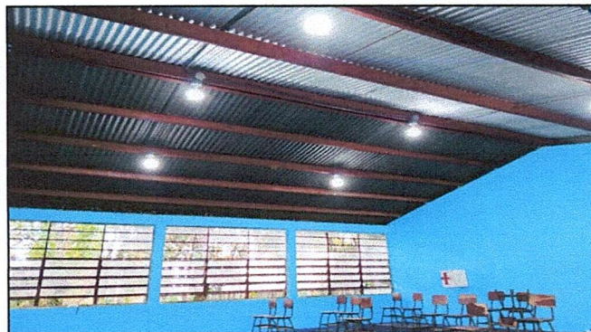
Foto 4: Sustitución de cableado eléctrico por cable No. 10
