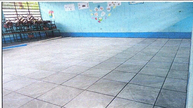
Foto 2: Sustitución de piso de torta de cemento por piso cerámico en aulas
