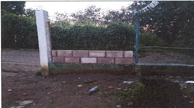
Foto 3: Mejoramiento de altura de muro perimetral
