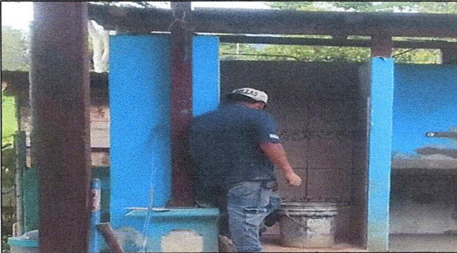
Foto1: Sustitución de azulejos en servicios sanitarios
