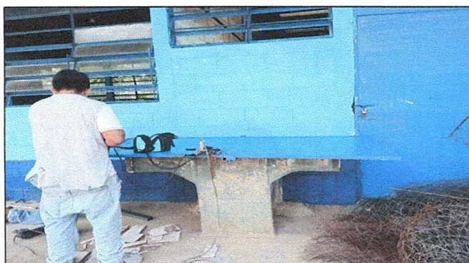
Foto 3: Sustitución de chapas de puertas de aulas
