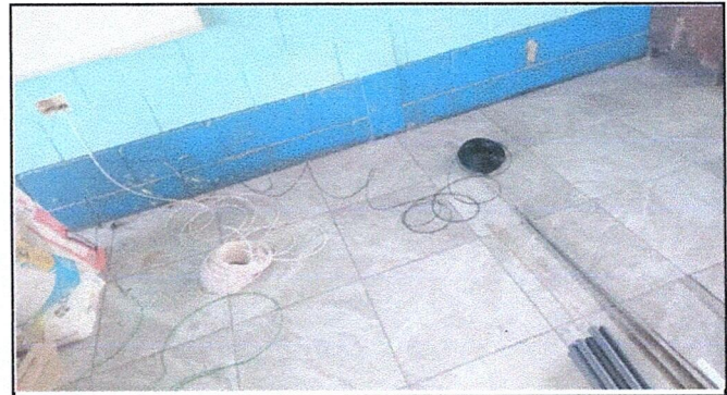
Foto 4: Sustitución de cableado eléctrico por cable No. 10
