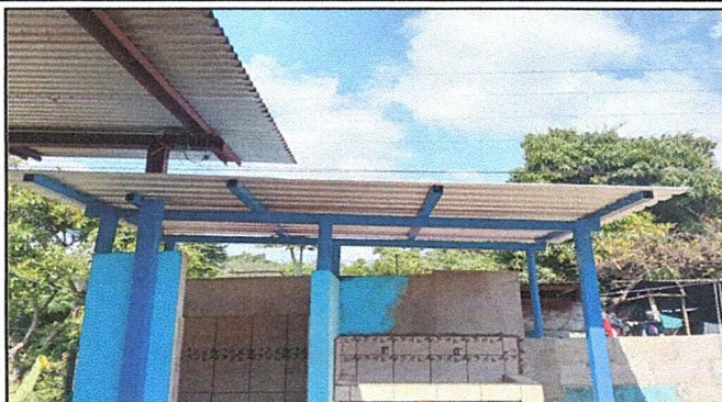
Foto1: Se realizara el cambio de estructura de techo + la sustitución de cubierta de lámina por lamina troquelada aluzinc calibre 26
