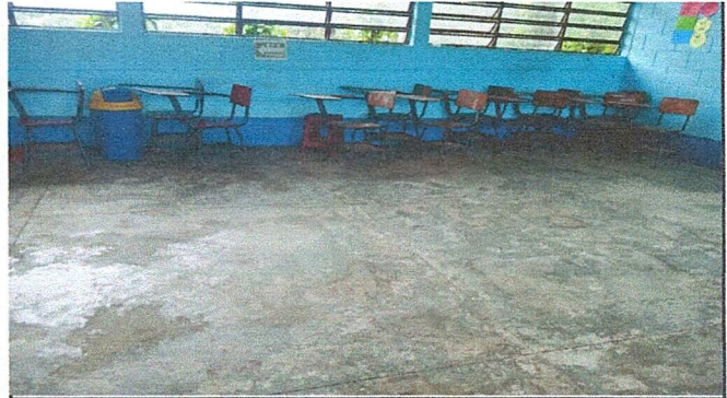
Foto 2: Sustrucción de piso de torta de cemento por piso cerámico en aulas
