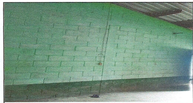
Foto 6: Aplicación de repello en área de cocina
