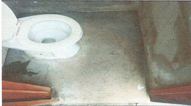
Foto 1: Sustrucción de azulejos en servicios sanitarios
