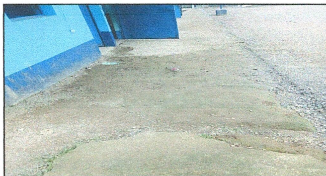
Foto 5: Reparación de banqueta de concreto
