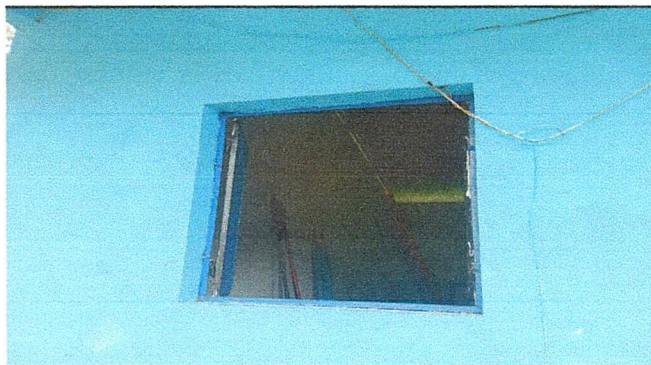
Foto 4: Suministro de balcon para ventanas PVC
