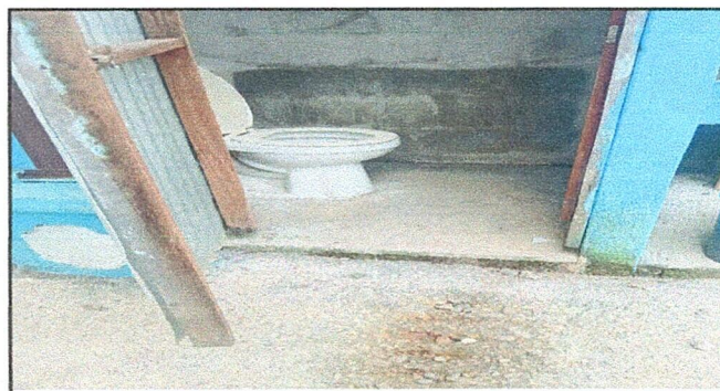
Foto 6: Sustitución de inodoros en servicios sanitarios
