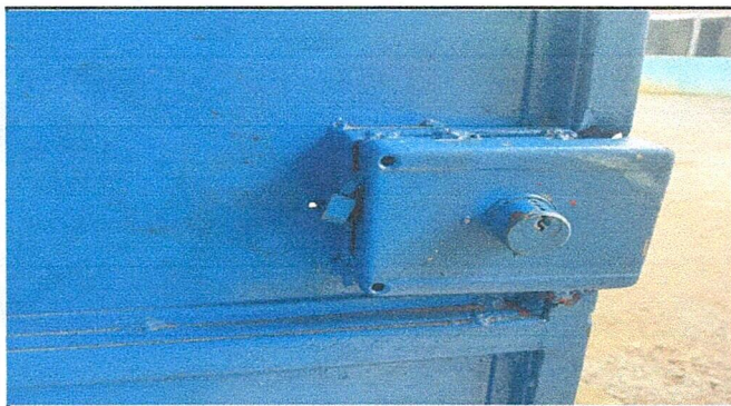
Foto 3: Sustitución de chapas de puertas de aulas
