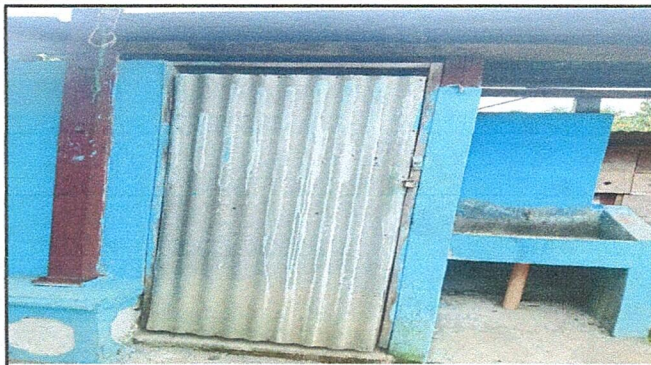
Foto 2: Sustitución de puertas de servicios sanitarios 1.00X2.00 MTS
