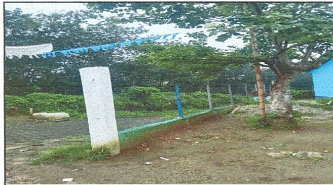
Foto 3: Mejoramiento de altura de muro perimetral
