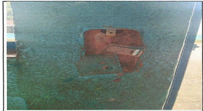
Foto 4: Sustrucción de cableado eléctrico por cable No. 10
