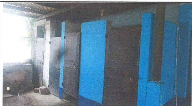
Foto 3: Aplicación de repello + cernido en paredes
