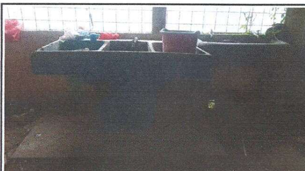
Foto 4: Sustitución de pila por pila de concreto
