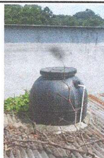
Foto 6: Sustitución de tanque elevado sobre módulo de baños
