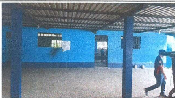
Foto 1: Aplicación de repello + cernido en paredes
