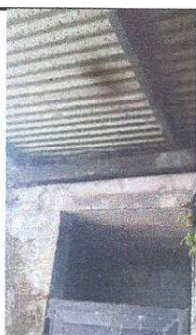
Foto 5: Sustitución de lámina por lámina troquelada aluzinc calibre 26
