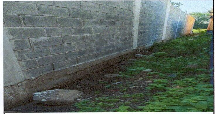
Foto 4: Aplicación de repello en pared de muro perimetral
