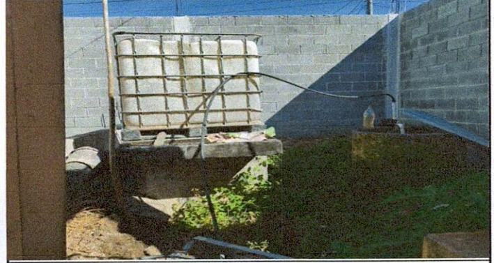
Foto 2: Se realizará la reparación de tubería de drenaje + tubería de agua potable
