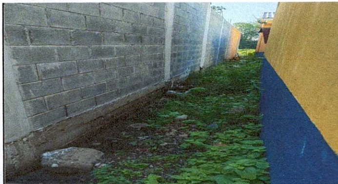
Foto 3: Reparación de losa de patio en área de cocina y parte posterior de módulo de aulas
