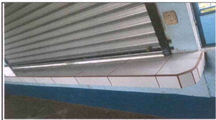
Foto 3: Revestimiento a mueble de existente con azulejos
