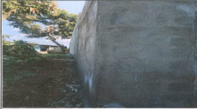
Foto 1: Aplicación de repello en muro perimetral
