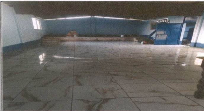
Foto 3: Instalación de piso ceramico en aulas
