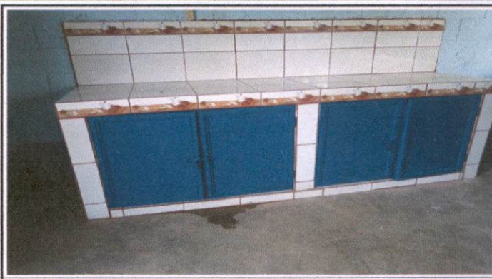
Foto 2: suministro de mueble de cocina con revestimiento de azulejo
