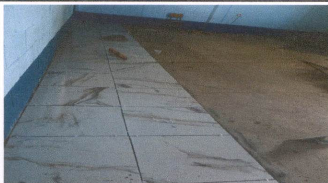
Foto 3: Instalación de piso ceramico en aulas
