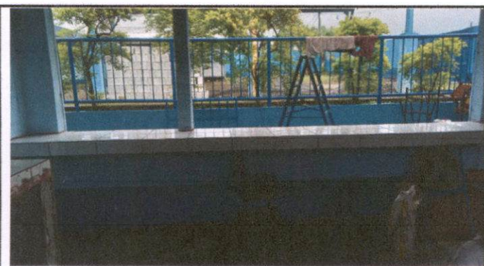
Foto 3: Revestimiento a mueble de existente con azulejos
