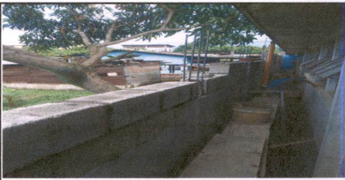
Foto 6: Continuación de muro perimetral
