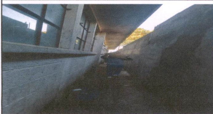
Foto 1: Aplicación de repello en muro perimetral
