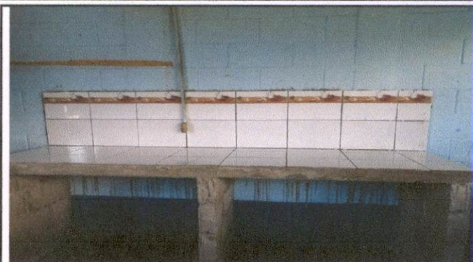
Foto 2: suministro de mueble de cocina con revestimiento de azulejo
