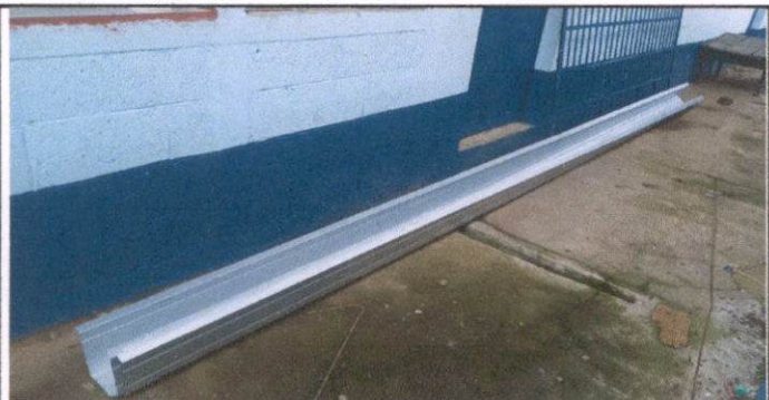
Foto 5: Instalación de canales y bajadas de agua pluvial
