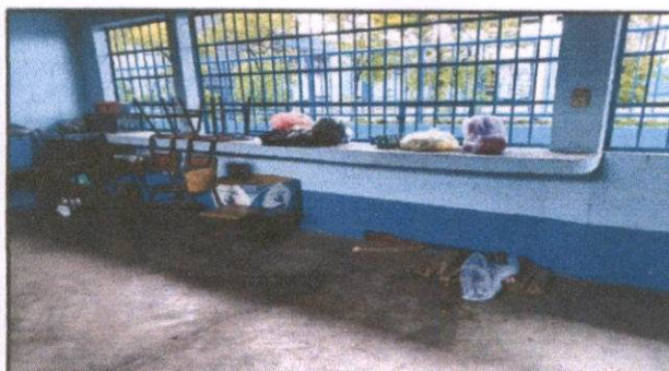
Foto 3: Revestimiento a mueble de existente con azulejos
