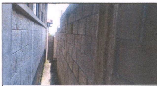
Foto 6: Continuación de muro perimetral
