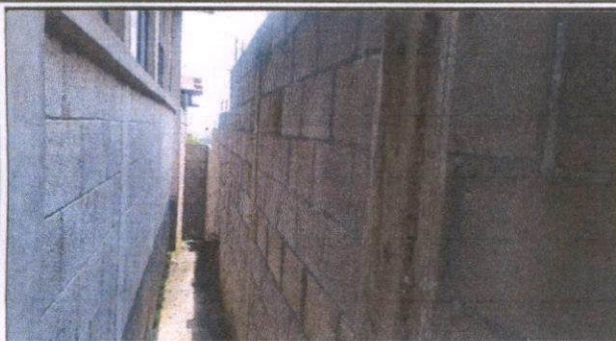
Foto 1: Aplicación de repello en muro perimetral
