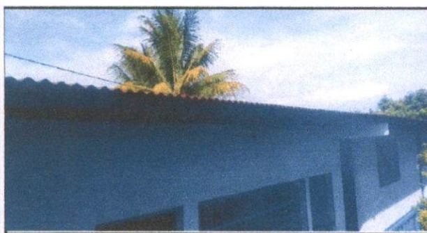
Foto 5: Se realizara la instalación de canales y bajadas de agua pluvial
