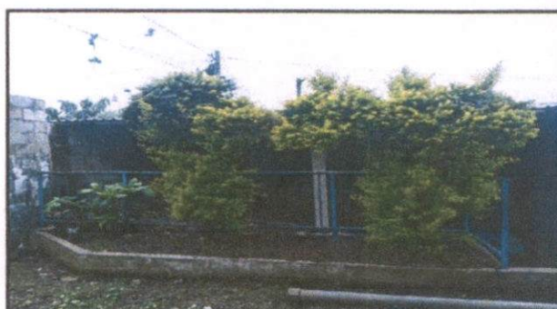
Foto 4: Suministro de base de concreto para deposito de agua potable
