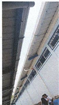
Foto 1: Sustiución de canal metal por metal y reparación de bajadas de agua pluvial.
