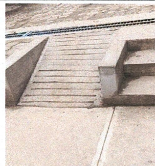
Foto 6: Sustiución de gradas por rampa de concreto
