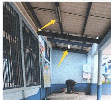
Foto 4: Sustiución de lámpara tipo LED
