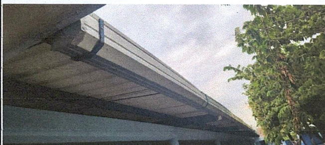
Foto 3: Sustiución de canal metal por metal y reparación de bajadas de agua pluvial.
