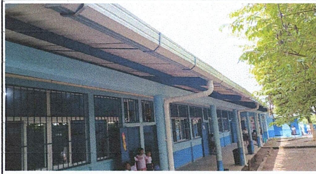
Foto 2: Sustiución de canal metal por metal y reparación de bajadas de agua pluvial.
