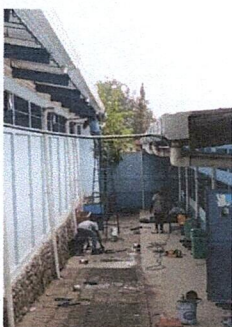
Foto 3: Sustitución de canal metal por metal y reparación de bajadas de agua pluvial
