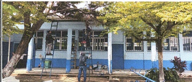
Foto 2: Sustitución de canal metal por metal y reparación de bajadas de agua pluvial
