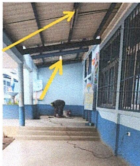
Foto 4: Sustitución de lámpara tipo LED
