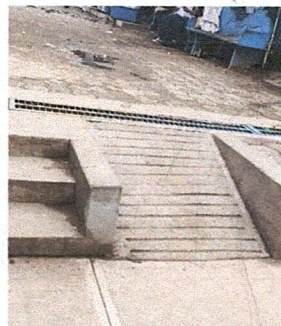
Foto 6: Sustitución de gradas por rampa de concreto
