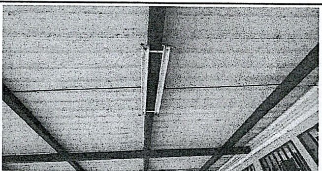
Foto 5: Sustrucción de lámpara tipo LED
