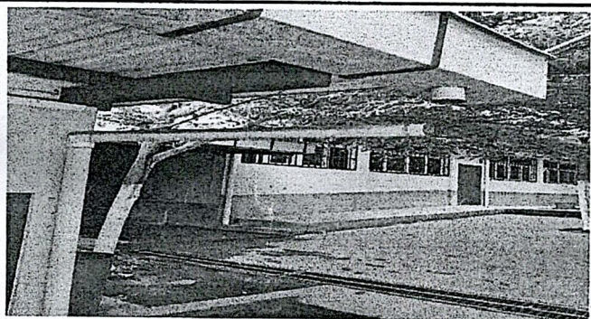
Foto 3: Sustrucción de canal metal por metal y reparación de bajadas de agua pluvial.
