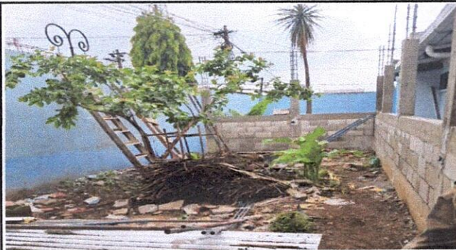
Foto 3: Suministro de repello cernido, losa de patio cubierta de lámina y balcones
