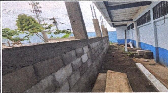
Foto 1: Suministro de repello y cernido, y balcones
