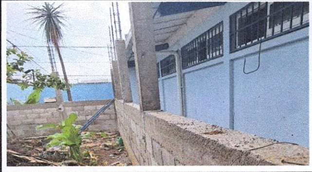
Foto 2: Suministro de repello y cernido, balcones y cubierta de lámina
