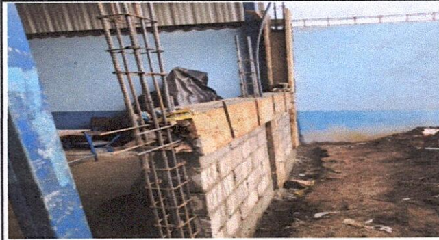
Foto 4: Suministro de repello, cernido y balcones
