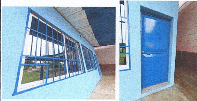
Foto 3: sustitución de puerta y ventana + balcón
