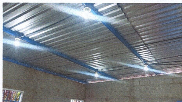
Foto 2: sustitución de estructura de soporte y sustitución de lamina troquelada
