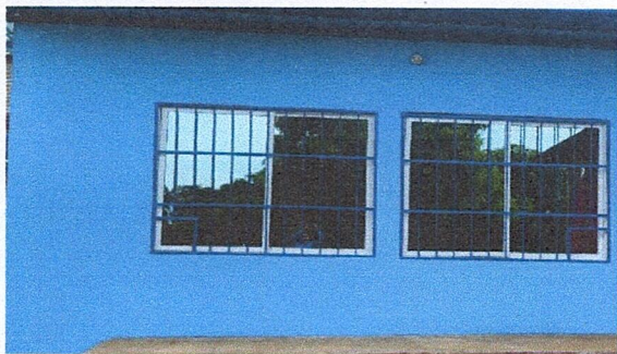
Foto 1: sustitución de malla existente por continuación de block en cocina
