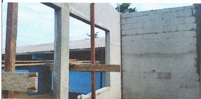
Foto 1: Sustitución de malla existente por continuación de block en cocina
