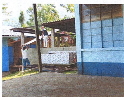
Foto 2: Sustitución de estructura de soporte y sustitución de láminas troqueladas
