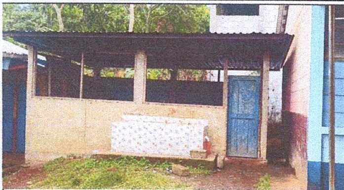
Foto 1: Sustrucción de maya existente por continuación de block en cocina
