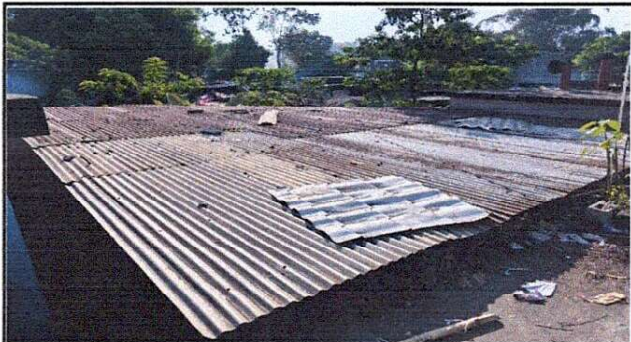
Foto 4: Sustitución de estructura + techo de lámina en módulo de cocina
