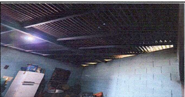
Foto 5: Reparación de sistema eléctrico
