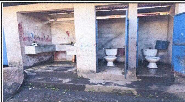
Foto 2: Sustitución de inodoros + sustitución de estructura y techo de lámina
