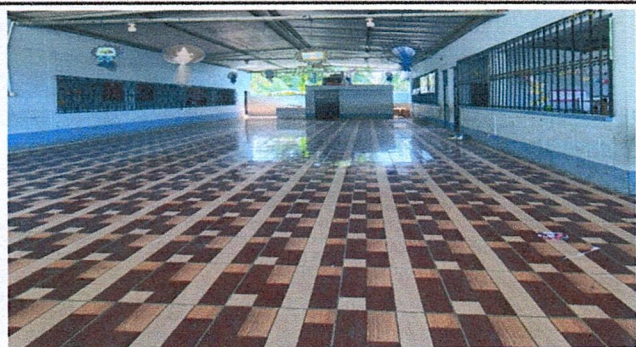
Foto1: Sustitución de piso de torta por piso cerámico en aulas y pasillo
