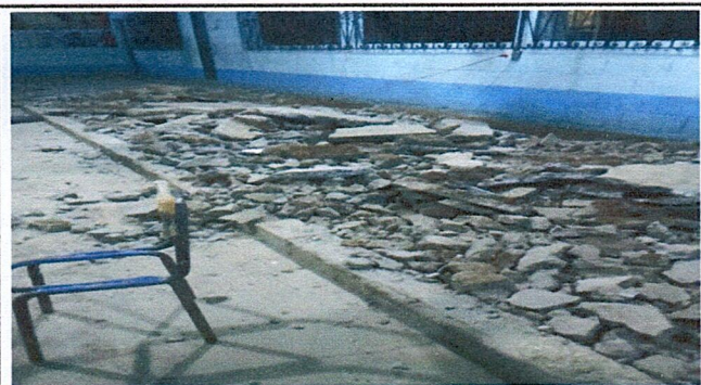
Foto1: Sustrucción de piso de torta por piso cerámico en aulas y pasillo
